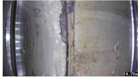
管桩接缝图
