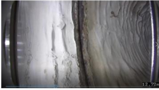
管桩接缝图
